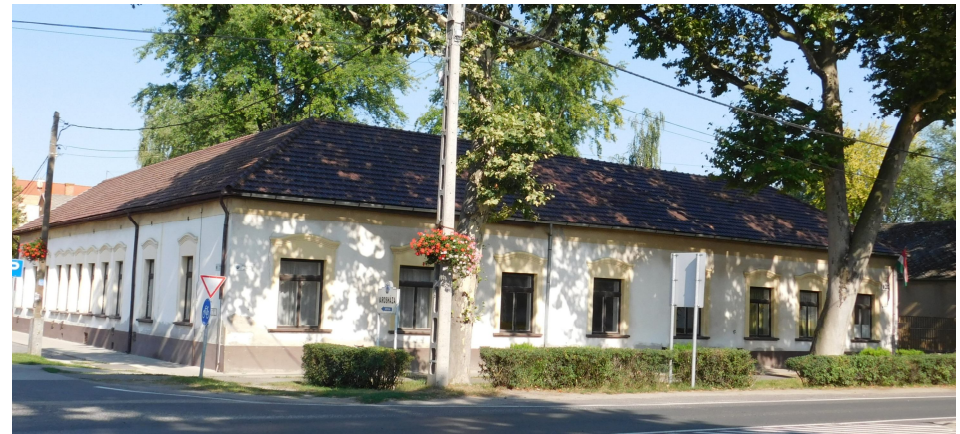
A „Sury-iskola” arányos, vakolatdíszes homlokzata
